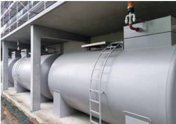
Generator-Tankanlagen.
