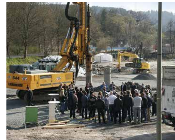
März 2014 – Spatenstich mit Abgeordneten des Landtages, dem Bürgermeister der Stadt Betzdorf, Architekten, Planer und Mitarbeitern der DCG.
