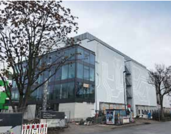
Main DC – Frontseite/Eingangsbereich vor der Fertigstellung.
