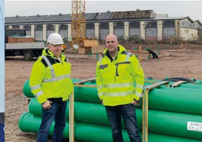
(v.l.) Unser DCG-Team Albert Gerhardus (Bauleiter) und Dennis Spies (Projektleiter) vor Ort.
