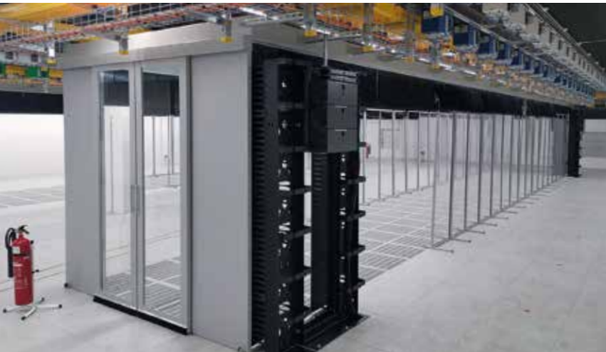
Innenausbau einer Data Hall.
