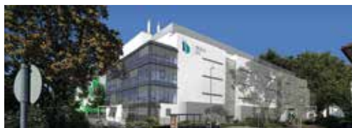
MAIN DC – Rechenzentrum auf Kurs Bauarbeiten trotz Corona im Zeitplan
