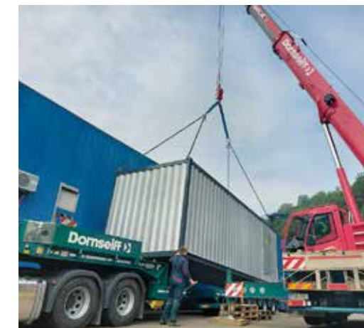
Der Rechenzentrumscontainer lässt sich auf normale LKWs verladen.
