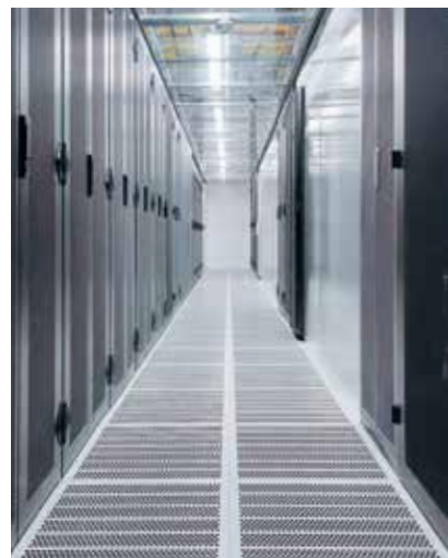
Kaltgangeinhausung des Testlab-Rechenzentrums von O 2 Telefónica in München.
