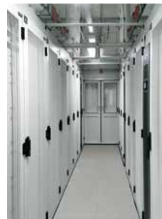
Strikte Trennung von Warm- und Kaltluft durch Kaltgangeinhausung.
