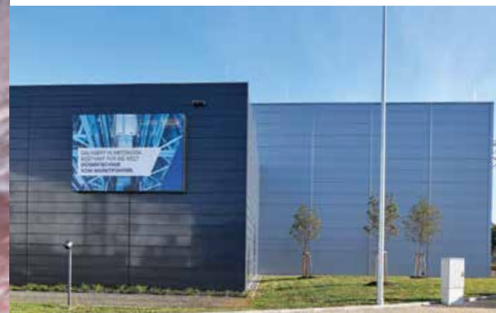
Das Firmengebäude von Lechler in Metzingen (Baden-Württemberg).
