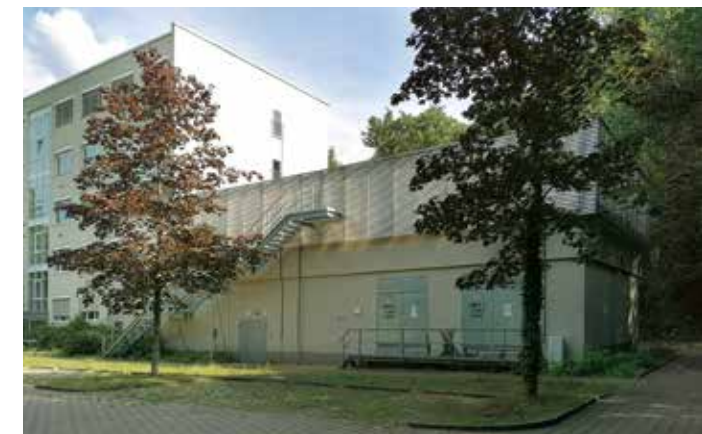
Außenansicht des ehemaligen Trafo-Gebäudes.
